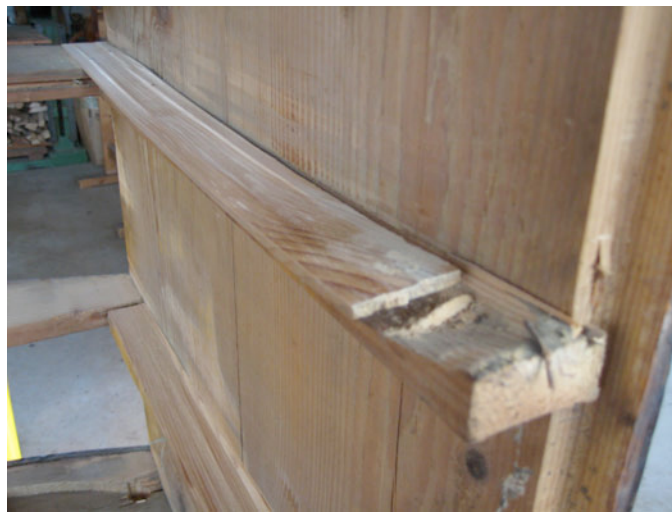
ausgelaufene Schubladenlaufleisten
